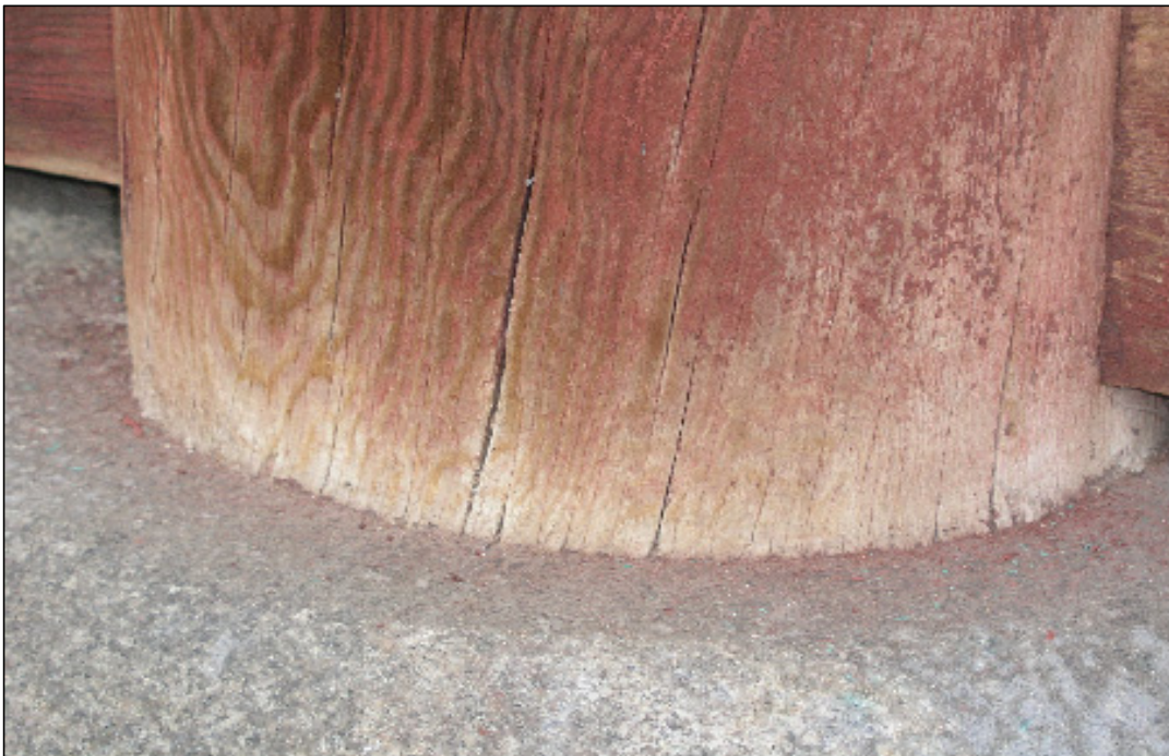
<사진1> 방염제로 인해 훼손됐을 것으로 추정되는 문묘(보물 141호) 명륜당의 바깥기둥 모습 1
