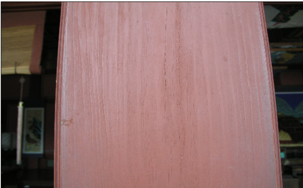
<사진> 방염제를 도포한 이후에도 상태가 양호한 화성행궁 봉수당 기둥의 모습
