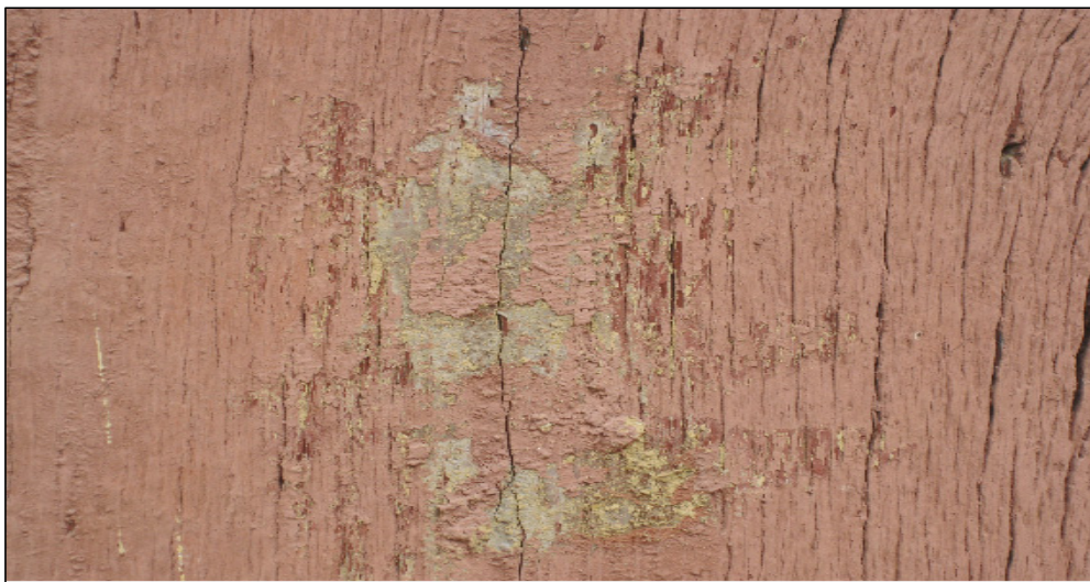
<사진> 방염제로 인해 단청이 떨어져 나간 것으로 보이는 선암사 대웅전 기둥의 모습 1
