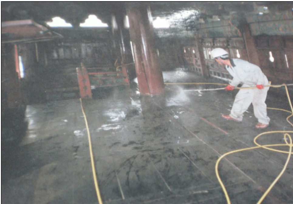
<사진> 화성 장안문 내부에 방염제를 도포하는 모습 (제공 : 수원시)
