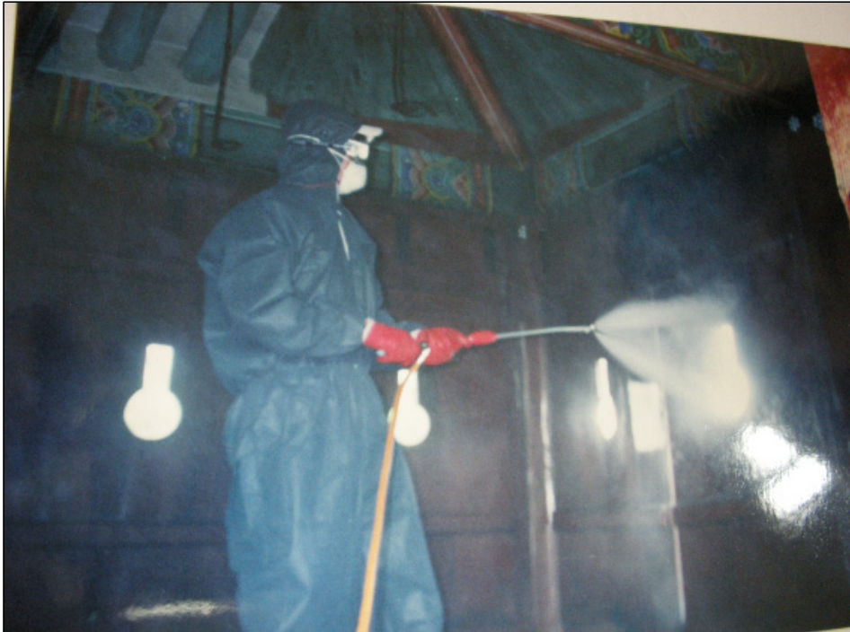
<사진> 화성 행궁 내부에 방염제를 도포하는 모습 1(제공 : 수원시)
