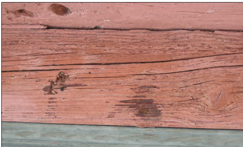
<사진> 방염제로 인해 단청이 떨어져 나간 듯 보이는 선암사 대웅전 기둥의 모습 2
