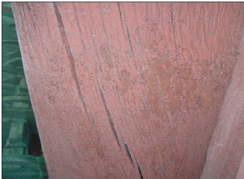
<사진4> 방염제로 인해 훼손됐을 것으로 추정되는 명륜당 바깥기둥 모습 4
