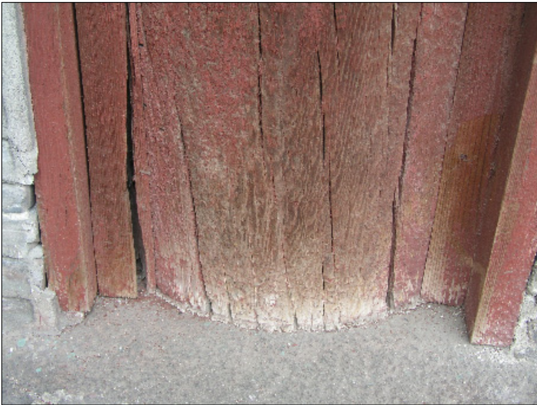
<사진2> 방염제로 인해 훼손됐을 것으로 추정되는 문묘(보물 141호) 명륜당의 바깥기둥 모습 2
