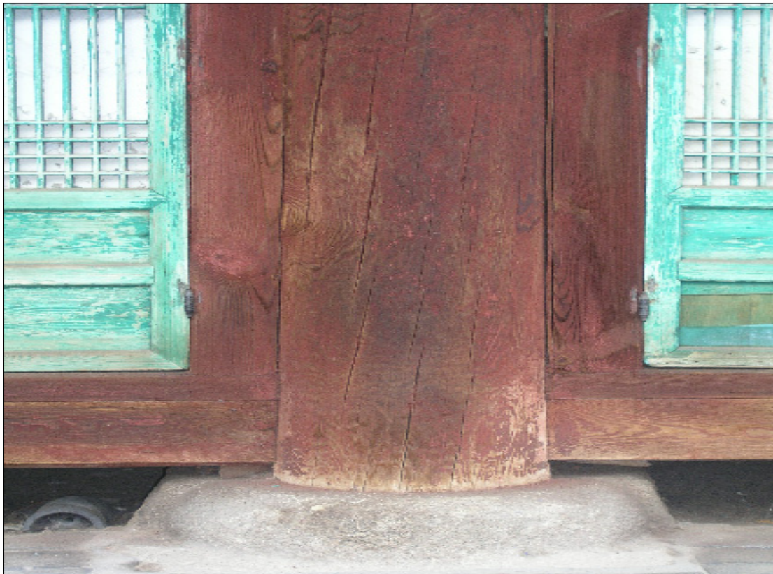
<사진3> 방염제로 인해 훼손됐을 것으로 추정되는 문묘(보물 141호) 명륜당의 바깥기둥 모습 3
