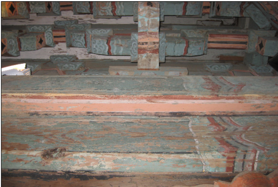
<사진2> 방염제로 인해 심하게 훼손된 미황사 대웅보전 내부의 모습
